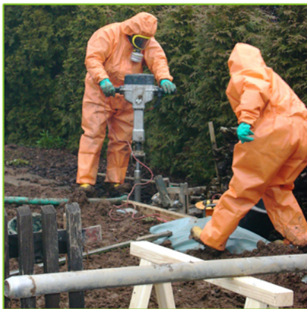
Rammkernsondierung auf belastetem Standort
