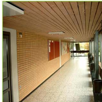
Holzpaneeldecke mit Flammenschutzanstrich
